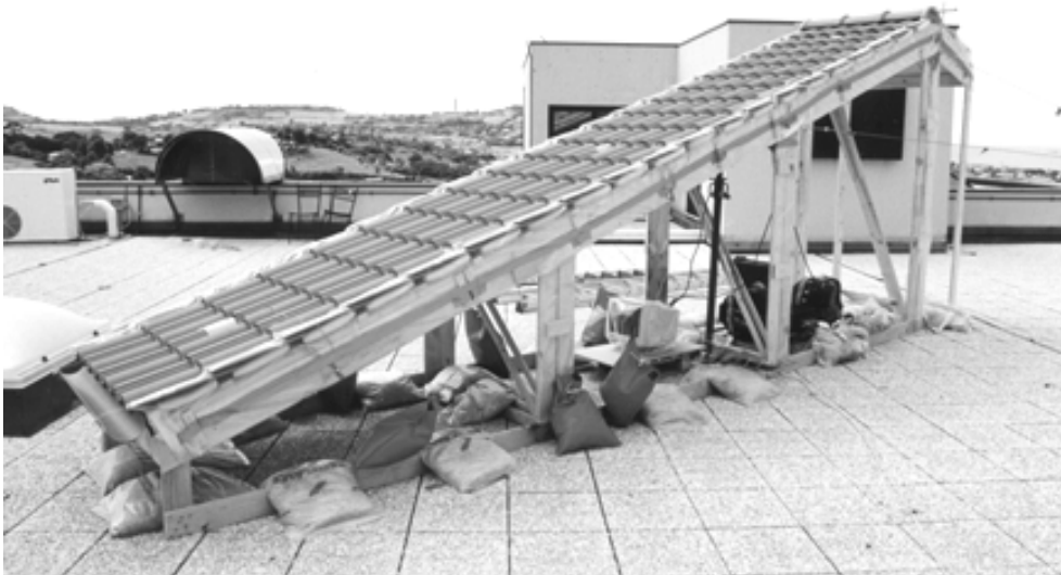
Fig. 2 Falda di copertura utilizzata per la sperimentazione. Prima della valutazione in esterno la stessa falda è stata utilizzata per misure sulla capacità di dissipazione del calore per mezzo di un sistema di irraggiamento simulato (piastre radianti di potenza nota). Ciò ha permesso di verificare l'attendibilità dei risultati forniti.
